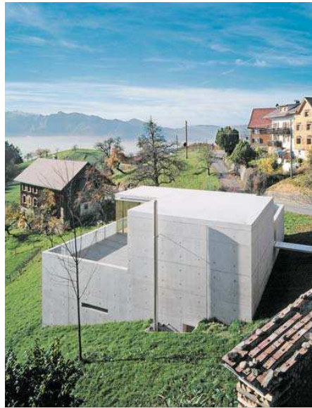
Haus Marte, Dafins, Marte.Marte Architekten. 1999
